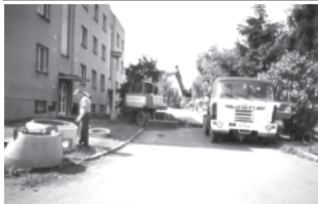
V ulici Pionýrův došlo z důvodu havarijního stavu k výměně vpustí kanalizace.
