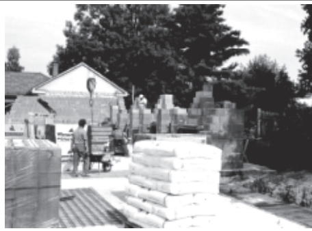
Stavba Domu s peč. službou zdárně pokračuje
