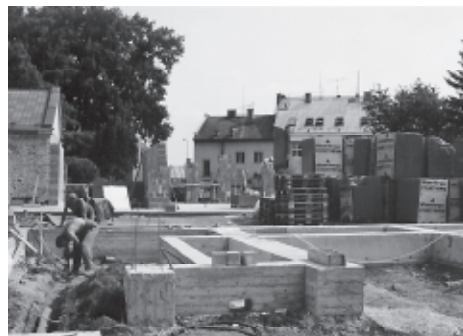
Výstavba Domu s pečovatelskou službou
