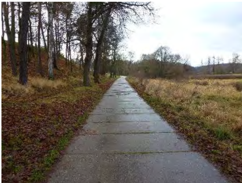
Pohled na komunikaci za ČOV ve směru ke konci úseku
