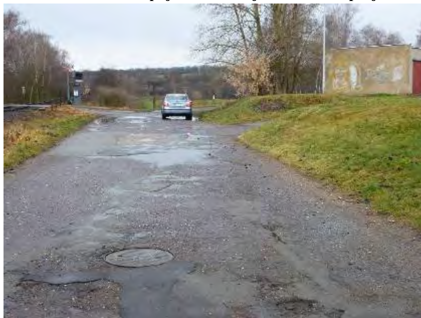
Konec úseku v napojení na stávající železniční přejezd
