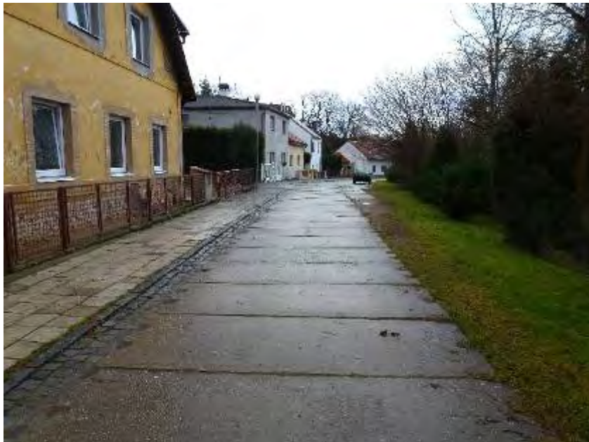
Konec úseku v místě napojení na Rybní Důl
