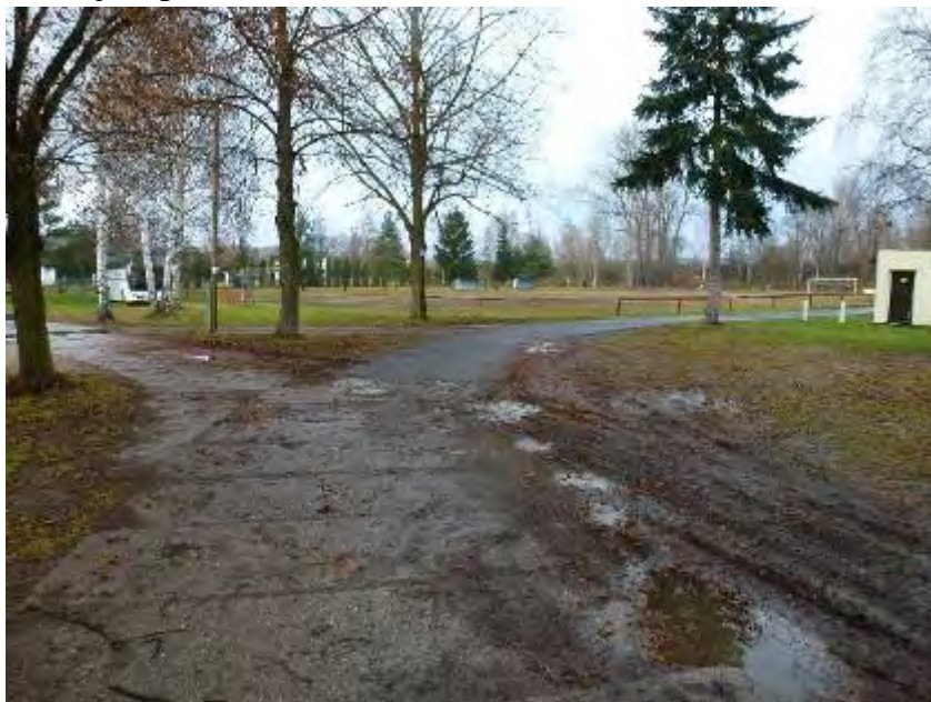
Napojení na již opravenou část komunikace ve směru k restauraci stadionu
