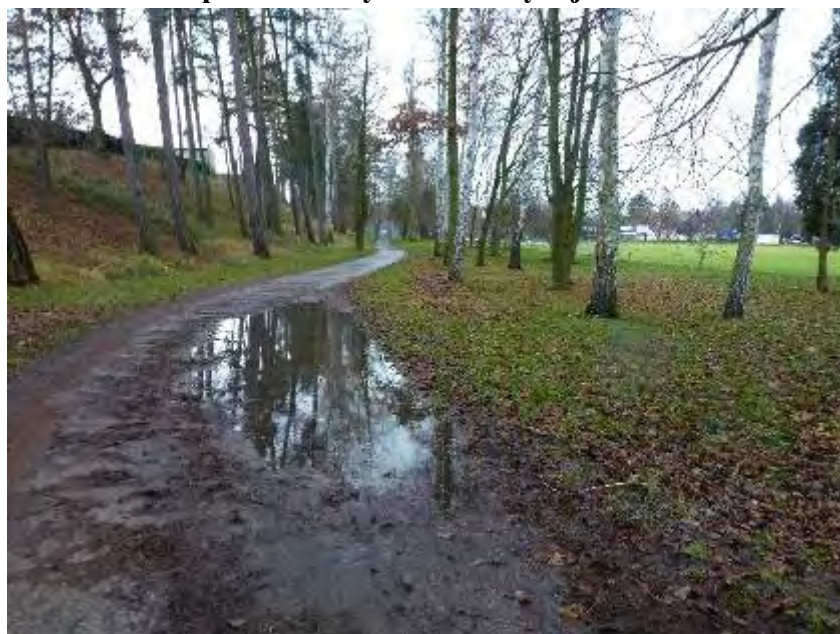
Pohled na průběh trasy v místě chybějícího odvodnění
