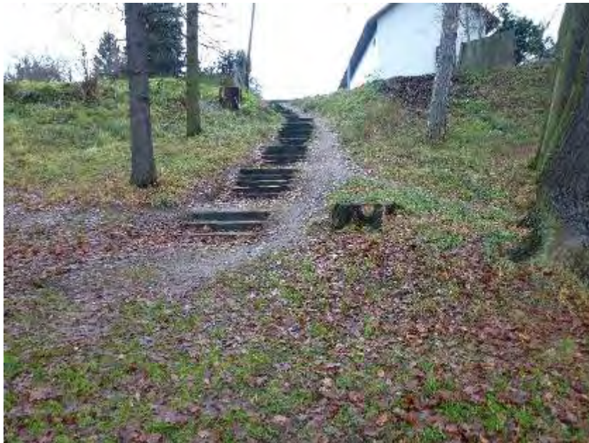
Pohled na stávající schodiště z ulice Nad Stráněmi
