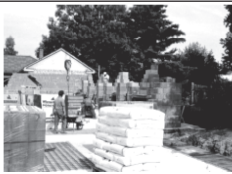
Stavba Domu s peč. službou zdárně pokračuje
