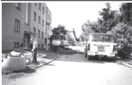
V ulici Pionýrů došlo z důvodu havarijního stavu k výměně vpustí kanalizace.
